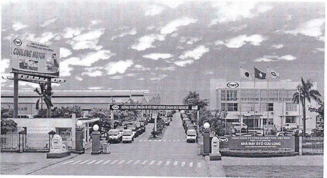
Quang cảnh Nhà máy ô tô Cửu Long - CUU LONG AUTOMOBILE FACTORY
